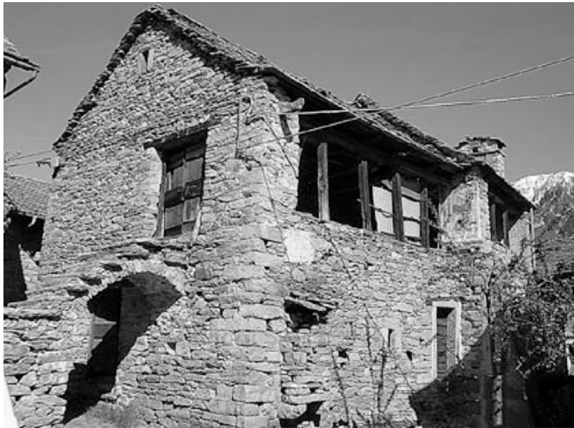
L'edificio a Montcrestese mostra le ridotte sporgenze della copertura a protezione dell'"astic", la pietra sagomata per reggere il canale di gronda, e le scale rampanti.
