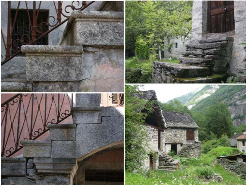
Pioda, q. 767, scala in pietra di un edificio ottocentesco, con dettagli realizzati con grande precisione: i gradini sono costituiti da un unico blocco in pietra lavorata e si appoggiano l'un sull'altro per pochi centimetri. I gradini si incastrano perfettamente con l'arco a sostegno del pianerottolo e sono sostenuti da una trave in pietra.
